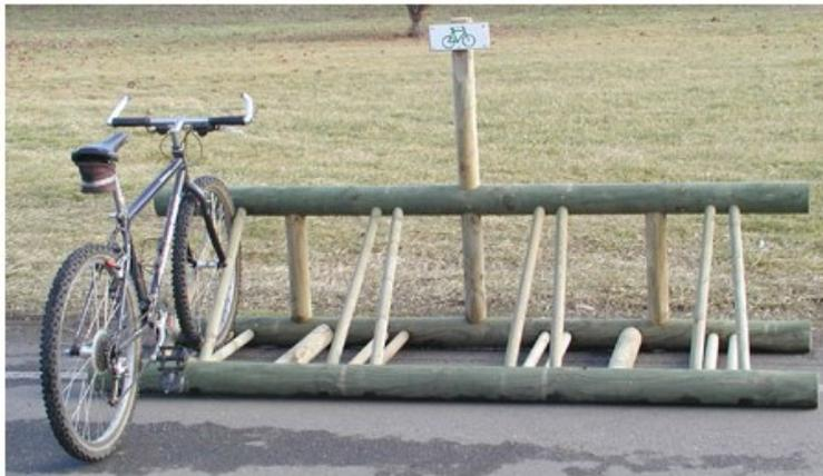
Pin traité autoclave classe IV. Structure en rondin diam. 10 cm.
